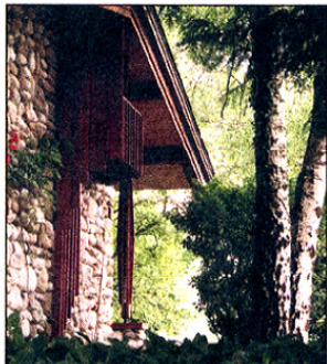
Del kamnite fasade Simonittijeve hiše v Špetru. Zgrajena je bila iz rečnih kamnov in obogatena z lesenimi detajli.
