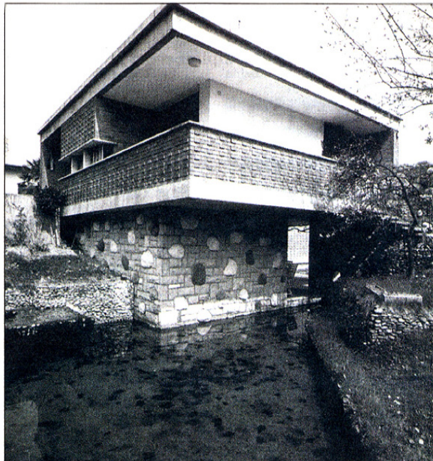
V vrtu hiše Giraldu je Simonitti oblikoval večjo vodno površino, ki odseva svetlobo tudi v dnevni prostor (Foto: Riccardo Toffoletti)
